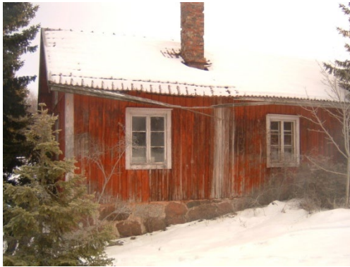
Lärbostad på Skoltomten 5:0 (nu fastighet 1:139, byggnaden har rivits 2018)
