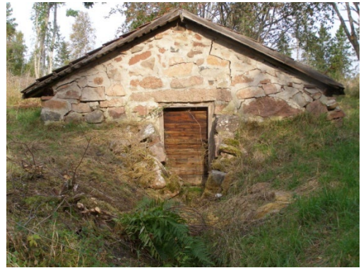
Jordkällare på Norrgård II 2:20 (nu fastighet 2:147)
